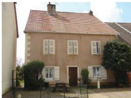
Chaînage d'angle en harmonie avec les encadrements de fenêtre.
